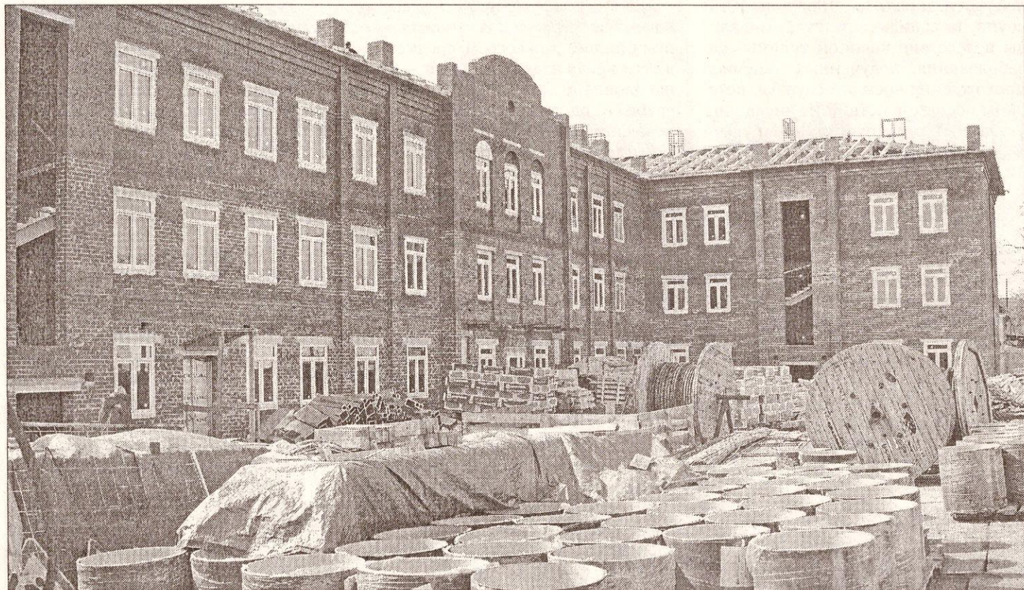
Здание нового бригадного дома общей площадью 4000 кв. метров состоит из двух блоков. В одном из них будет располагаться сама гостиница вместимостью 76 человек, во втором – большая столовая, вспомогательные и офисные помещения. На переднем плане фото видны рулоны железа для фальцевой кровли. Она будет аналогична той, что сделана на железнодорожном вокзале, но зелёного цвета.
